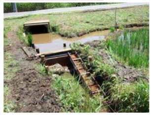
今までの取水口は単なる土嚢積みのため、大雨の度 に崩壊し水管理も大変なことから、木製ですが杭で固 定し角落とし堰に改良しました。これで水位調整も楽 にできます。
