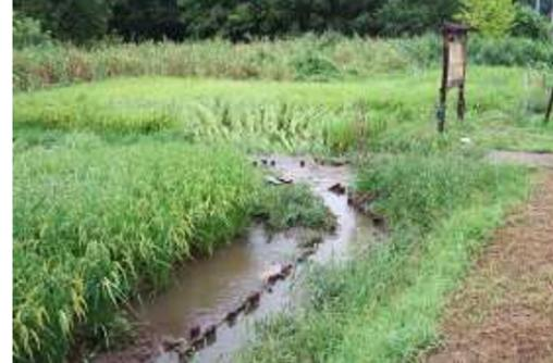
固定堰の下が潜掘漏水
